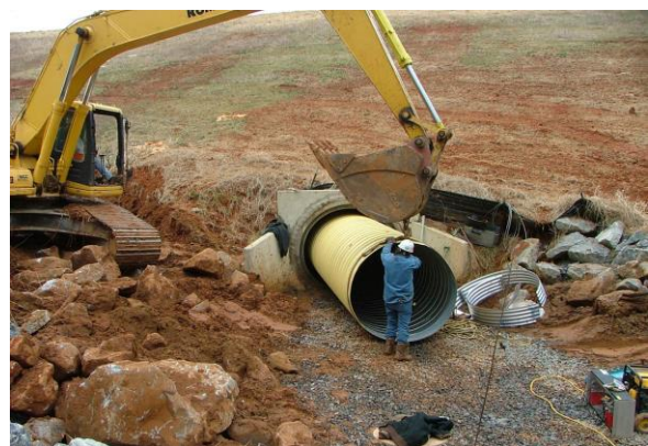
Рис. 1. Гільзування дорожньої водопропускної споруди
